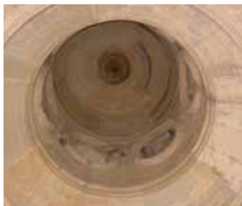
21. Otvory ve stěně kaple
